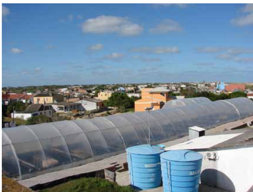
FIGURA 5 | ESTRUTURA DE ESTUFAS PARA TESTES PILOTO COM TANQUES REVESTIDOS DE GEOMEMBRANA® (PEAD) NA ESTAÇÃO MARINHA DE AQUACULTURA DA FURG; RIO GRANDE, RS
