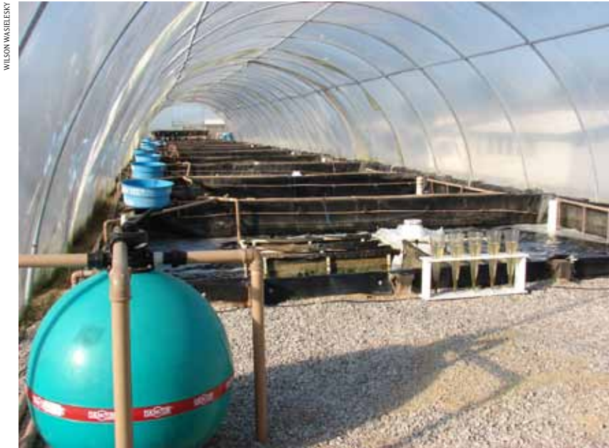
FIGURA 2 | ESTUFA (585M 2 ) PARA TESTES PILOTO COM TANQUES REVESTIDOS DE GEOMEMBRANA® (PEAD) NA ESTAÇÃO MARINHA DE AQUICULTURA DA FURG; RIO GRANDE, RS
