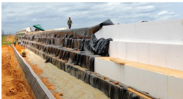
Figura 01 - Rodovia construída com a utilização de EPS
